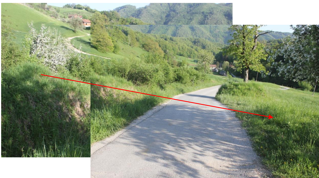
Pogled na začetek poškodovane ceste in smer premikov
