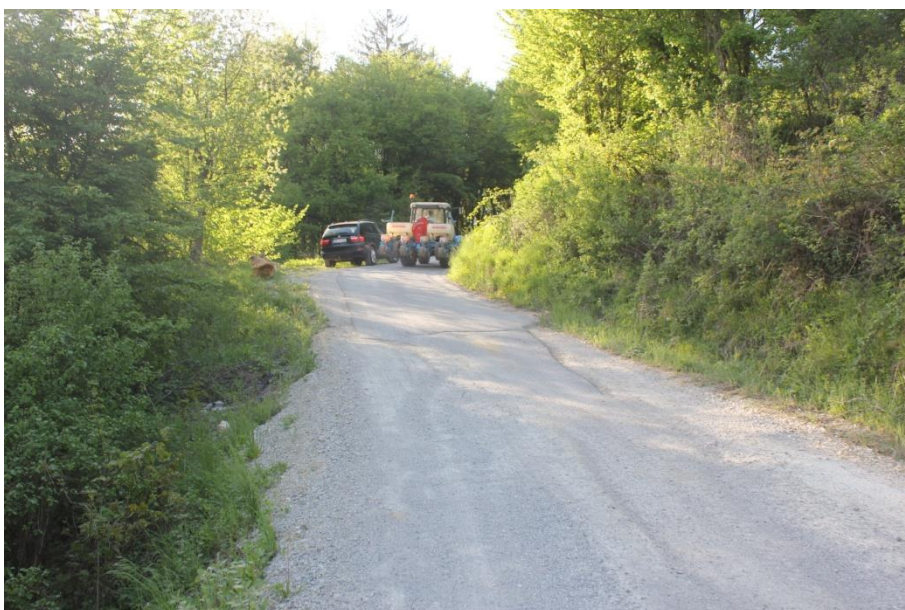
Pogled v območje kjer je zdrsnila cesta v dolžini cca 30m in je dograjena z gramozom.
